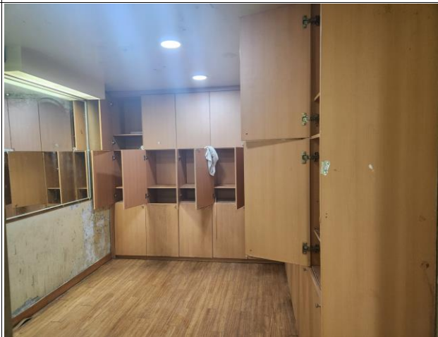
탈의실 바닥/벽체/천장 철거후 재시공(락카포함 재시공)
