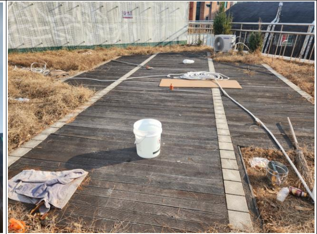
육상 바닥데크 철거후 재시공(오일스테인 마감포함)
