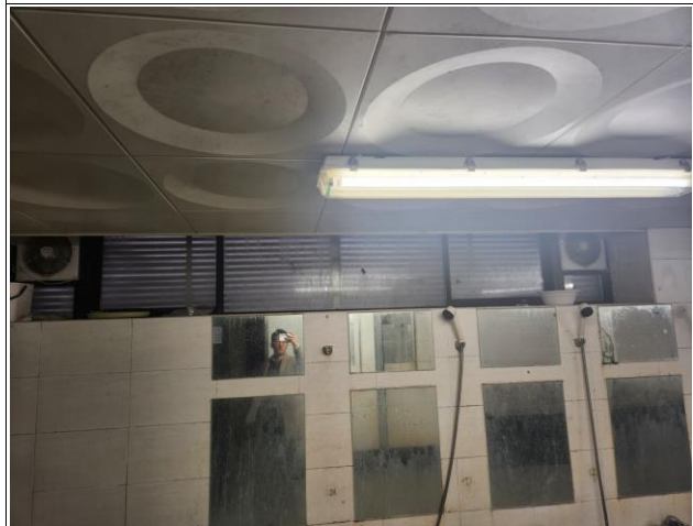
샤워실 환풍기 철거후 재시공(기존 AL창호 존치, 옛칭필름 시공)
