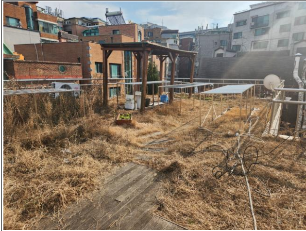
육상 목재시설물 오일스테인 마감(기존 목재부재 존치)
