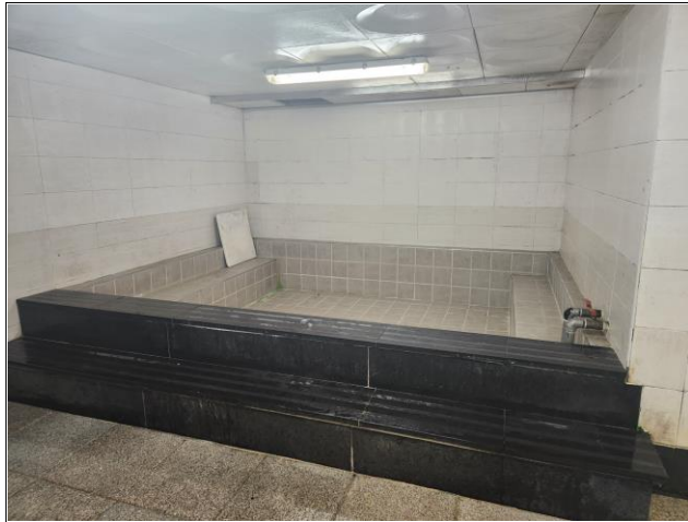
B1F 샤워실 탕 철거 후 재시공
