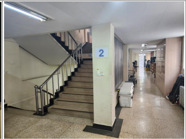
공용구간(복도, 계단실) 벽체 도장 + 도어 및 철재(서터등) 도장공사 포함 + 천장 기존천장(석고보드)위 도장공사 포함 (바닥은 공사제외)
