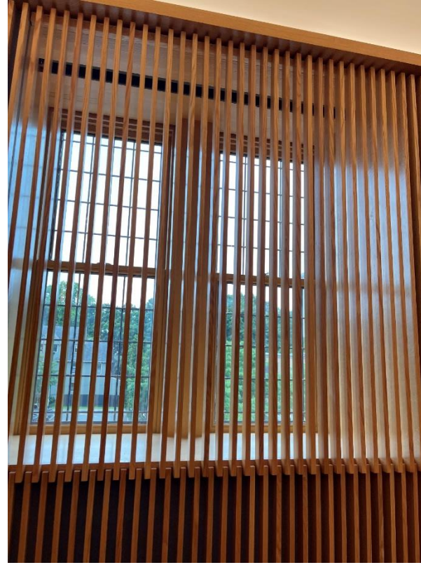
창호 내측 - 목재 루바 시공 (은은한 분위기 연출)
