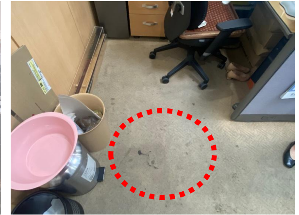
바닥 카펫 철거후 지정 데코타일 교체 ('상임이사실'과 동일한 자재 활용)
