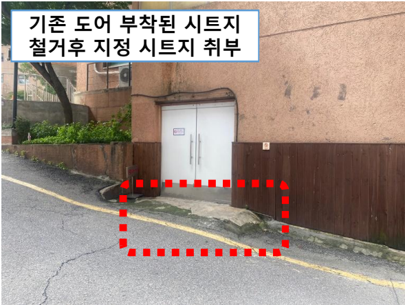
우수 유입방지 위한 철거후 트렌치 설치 및 파이프 매입
