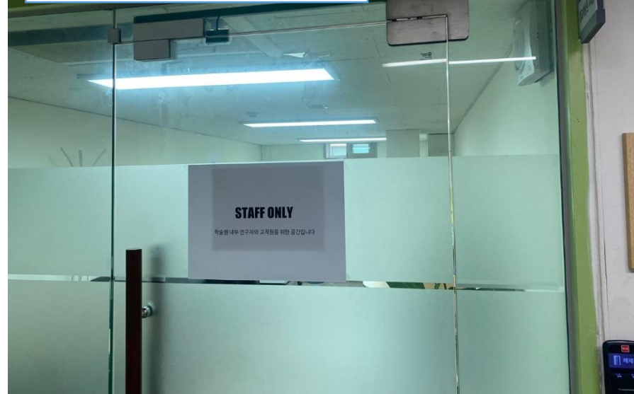
출입문 - 강화유리도어 신설 및 안개무늬 시트지 취부
