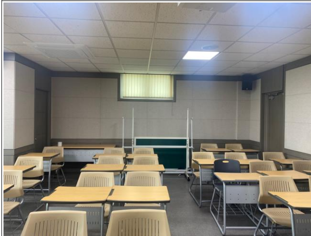
501-433 내부 모든 시트지 철거 후 재시공
