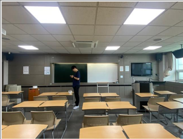
501-433 내부 모든 시트지 철거 후 재시공( 집기이동 및 보양)
