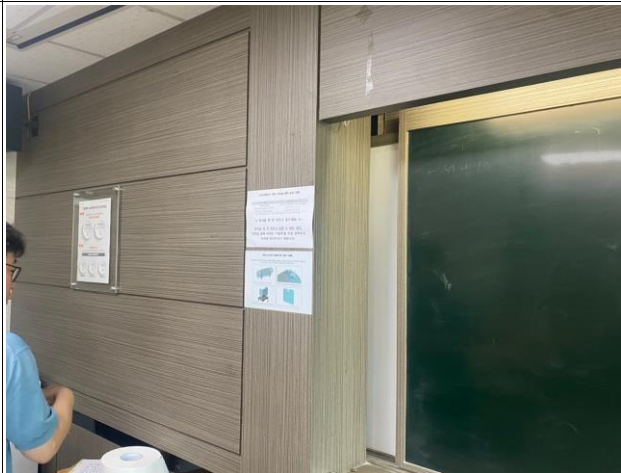
501-433 내부 모든 시트지 철거 후 재시공(칠판 뒷판 포함)
