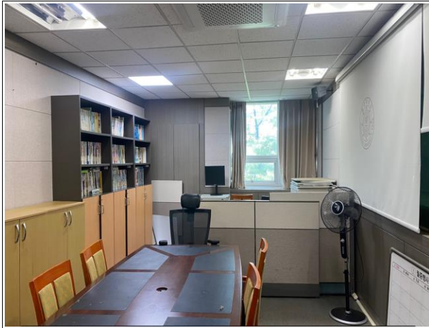
501-331 내부 모든 시트지 철거 후 재시공(가구 제외)
