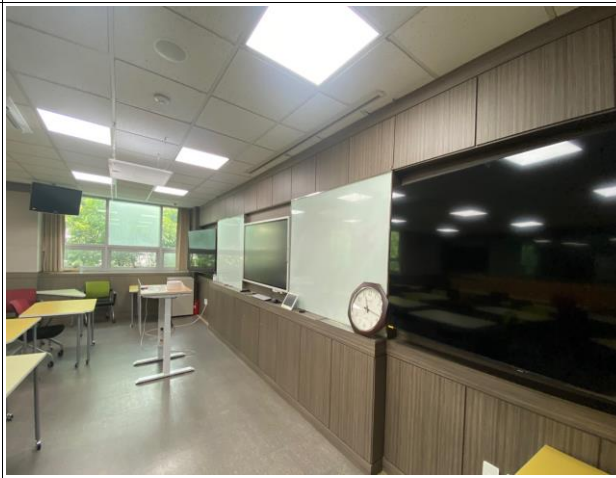
501-333 내부 모든 시트지 철거 후 재시공(철판뒷판, 창호하부 상단면포함)
