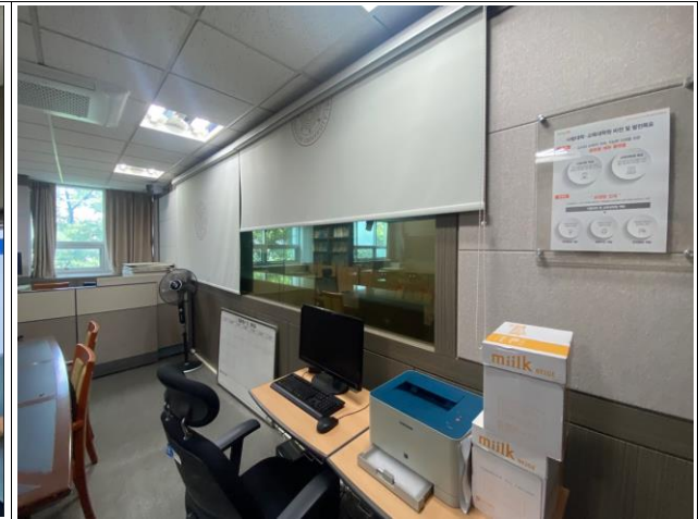
501-331 내부 모든 시트지 철거 후 재시공(상부 몰딩부 포함)
