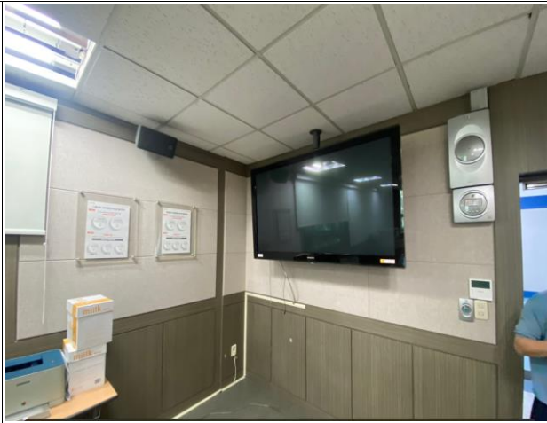
501-331 내부 모든 시트지 철거 후 재시공(문틀, 문짝 포함)
