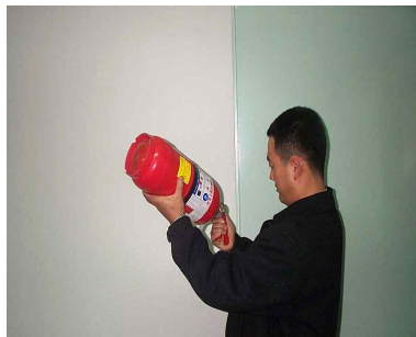
축압식 소화기의 압력상태 점검
