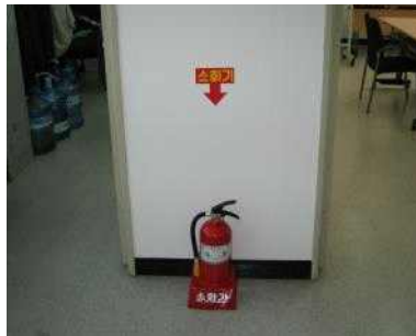
소화기표지 설치상태 점검
