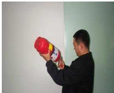
축압식 소화기의 압력상태 점검
