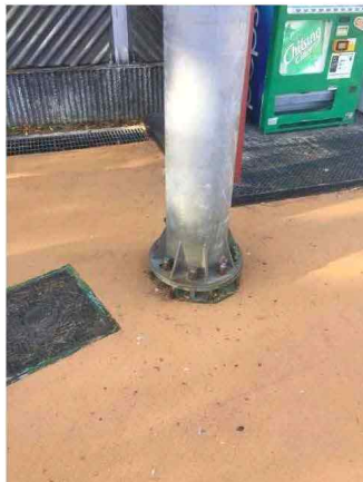
사진1 조명탑 하부 시공상태
