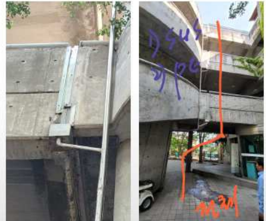
콘크리트 연결부 백화/석회수로 인한 우수 배수관 교체 재시공 必
