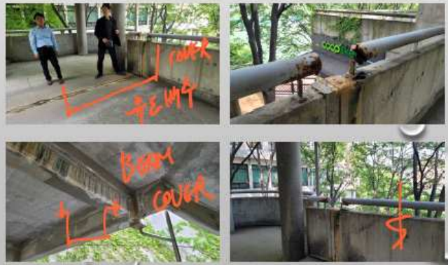
콘크리트 연결부 백화/석회수로 인한 우수 배수관 교체 재시공 必
