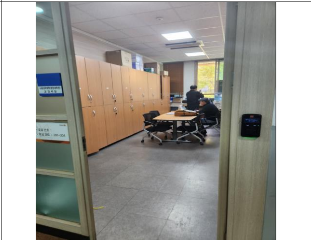
라운지 조성공간(벽체, 천장, 바닥 철거 후 재시공)
