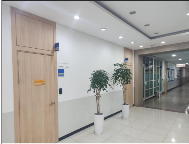
라운지 설치구간 복도(경량벽 + 유리벽)
