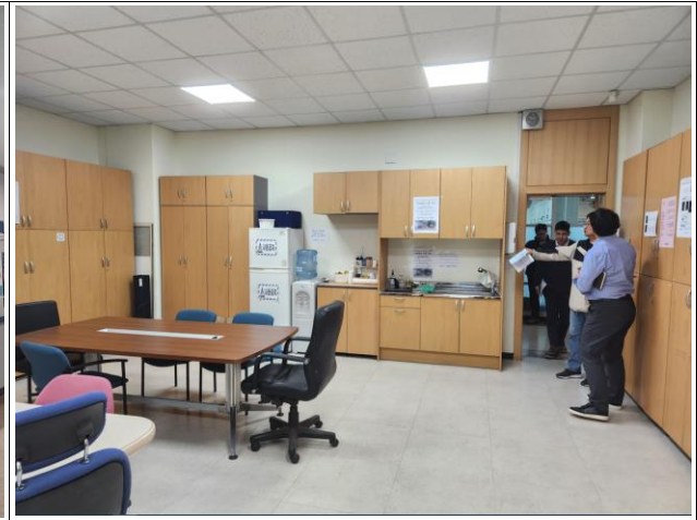
원장실/학장실 신규조성(집기이동 및 재배치, 간벽설치 등)
