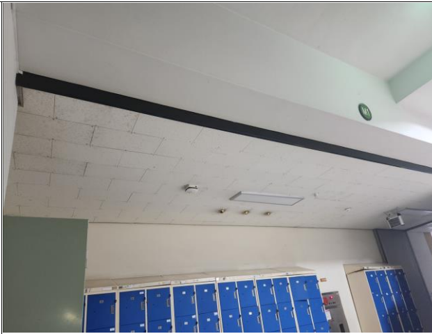
사회과학관 1F 석면철거 및 천장시공 (LED, 스피커, 감지기 등 임시철거후 재설치)
