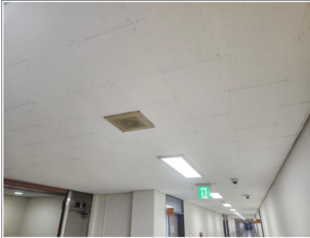
문화관 3F 석면철거 및 천장시공 (LED, 스피커, 감지기 등 임시철거후 재설치)
