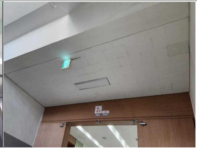
사회과학관 2F 석면철거 및 천장시공 (LED, 스피커, 감지기 등 임시철거후 재설치)
