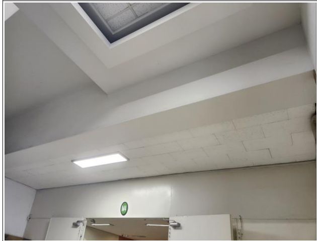
사회과학관 4F 석면철거 및 천장시공 (LED, 스피커, 감지기 등 임시철거후 재설치)
