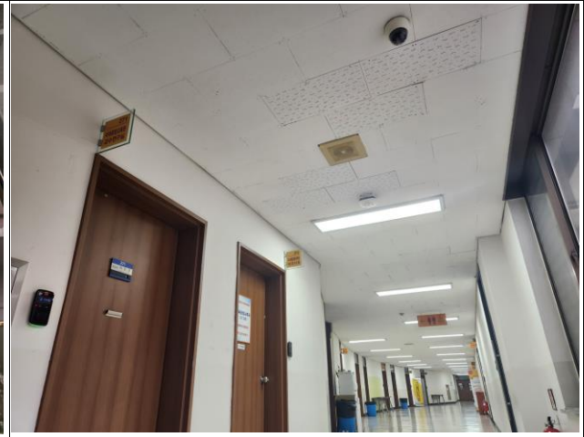
학술관 2F 석면철거 및 천장시공 (LED, 스피커, 감지기 등 임시철거후 재설치)
