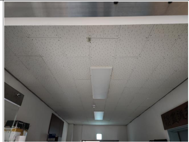
사회과학관 5F 석면철거 및 천장시공 (LED, 스피커, 감지기 등 임시철거후 재설치)
