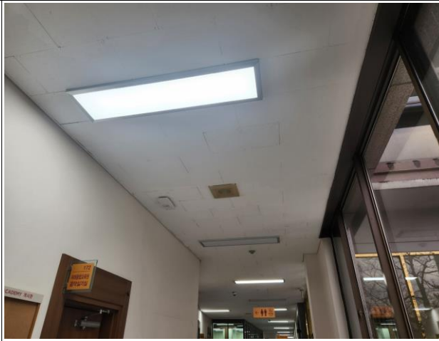
학술관 1F 석면철거 및 천장시공 (LED, 스피커, 감지기 등 임시철거후 재설치)
