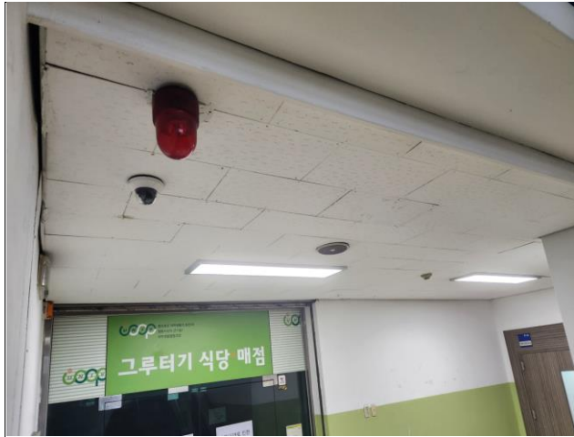
사회과학관 B1F 석면철거 및 천장시공 (LED, 스피커, 감지기 등 임시철거후 재설치)
