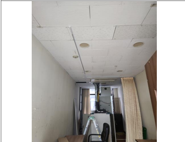
학술관 3F 석면철거 및 천장시공 (LED, 스피커, 감지기 등 임시철거후 재설치 / EHP 및 각종 장비 보양)
