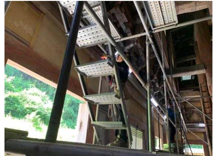
비계 설치(예시 사진)
