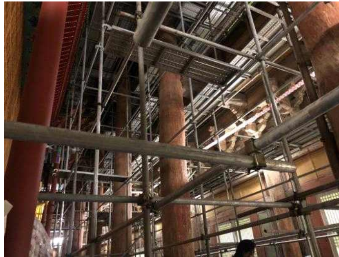
비계 설치(예시 사진)
