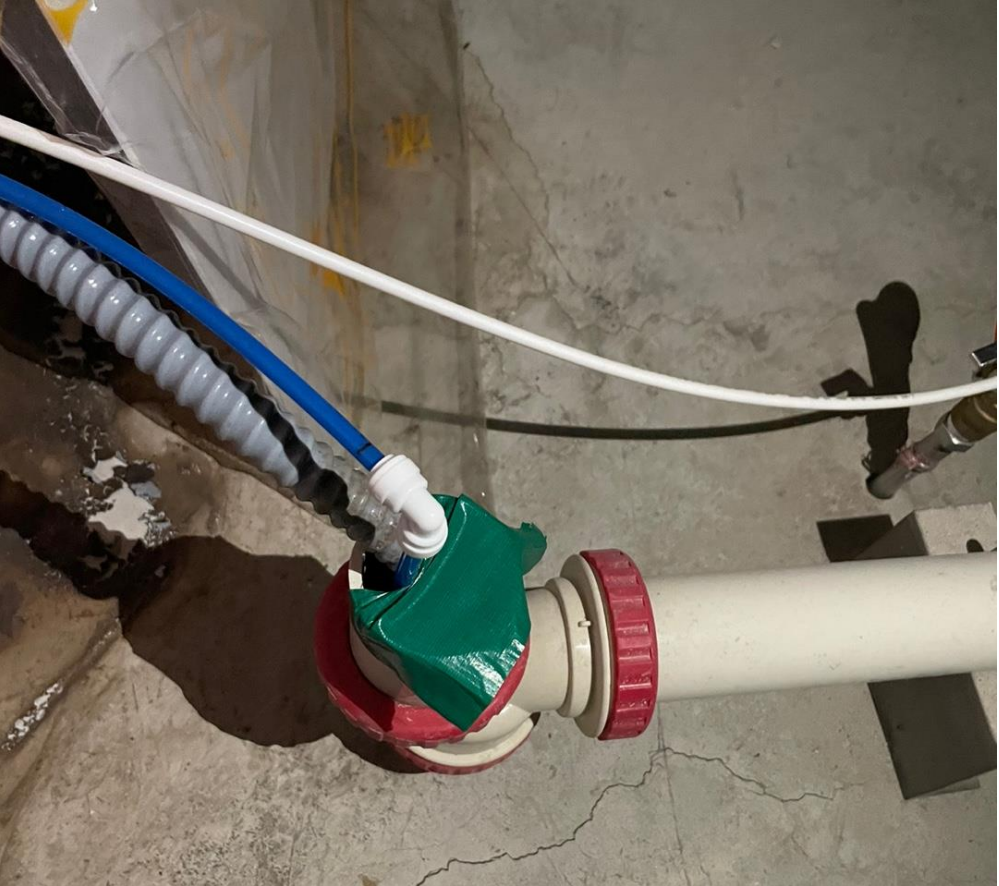
기존 드레인 배관에 연결 설치할 것 - 마감철저히 할 것 (사진에서처럼 테이프로 마감하면 X)
