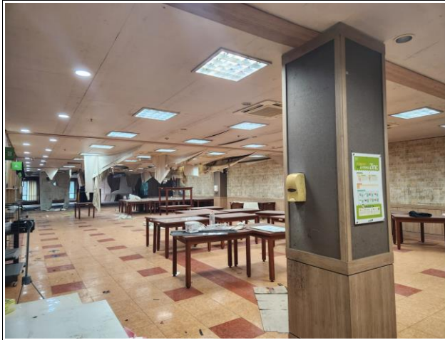
식당(202-B191) 바닥/벽체(기둥)/천장철거 및 폐기
