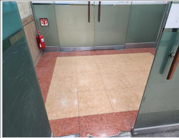
방풍실(202-B199 우측) 바닥/벽체/천장 철거 및 폐기 (SSD 존치)
