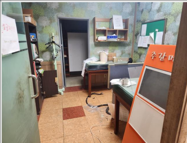
(구)사무실 가설벽(유리+경량벽) 및 내부 집기류 철거 및 폐기
