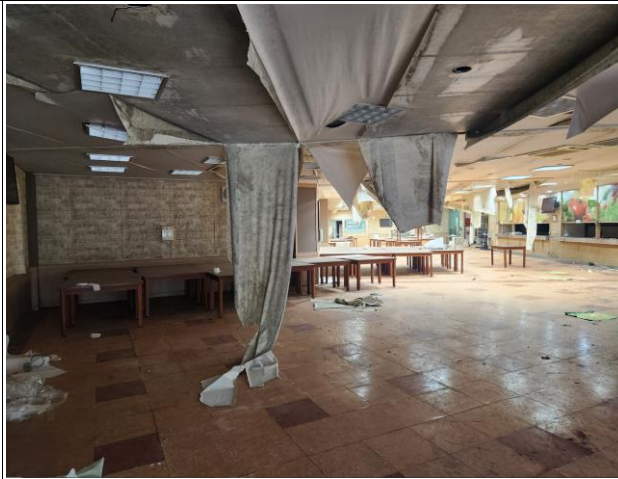
식당(202-B191) 집기(테이블 60여개) 철거 및 폐기
