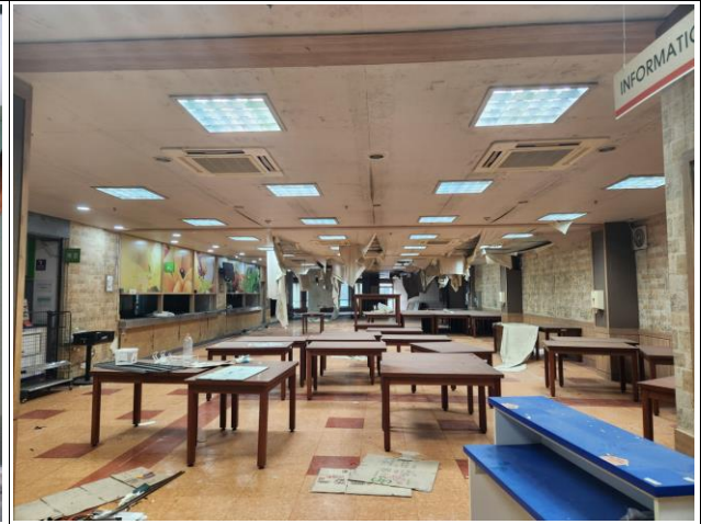
식당(202-B191) 천장 매립/부착물 철거 및 폐기
