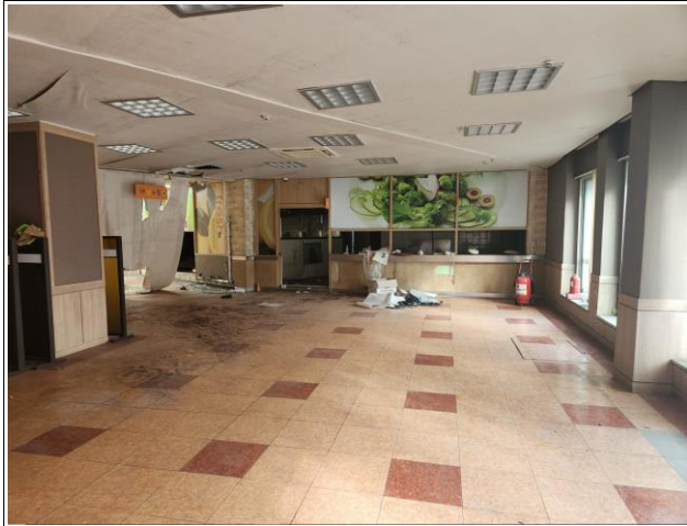
식당(202-B191) 주방 및 외부장호 제외 모든 마감재 철거 및 폐기
