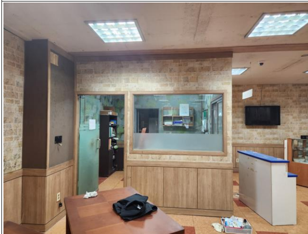
(구)사무실 가설벽 및 내부 집기류 철거 및 폐기
