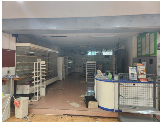
(구) 편의점 바닥(물탈 및 하지를 포함) / 천장 / 벽체 철거 및 폐기
