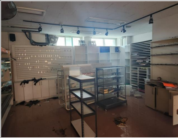
편의점 내부 선반, 냉장고 등 모든 물품 철거 및 폐기
