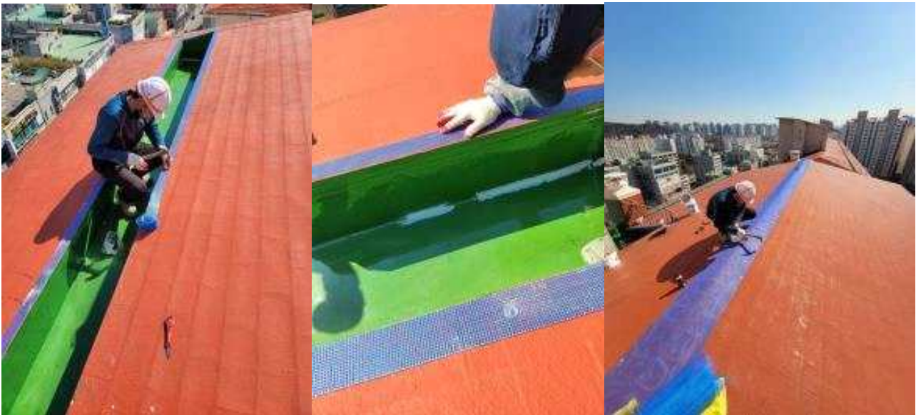
< 가장자리, 용마루 매쉬 부착 및 앵커 볼트 설치 >
