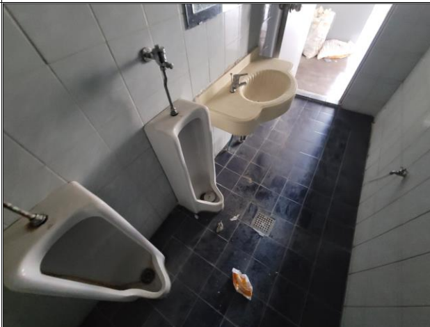
화장실 벽타일, 바닥타일, 천장 철거후 신규시공 (큐비클, 위생도기 철거 건축공사 포함)
