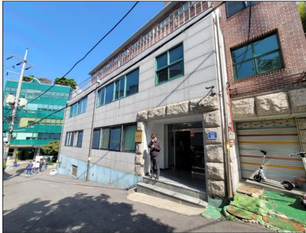
필동관 창호 확장설치에 따른 석재/골재 커팅후 신규창호 설치 및 석공사 마감(창대석, 메지 실리콘 포함)
