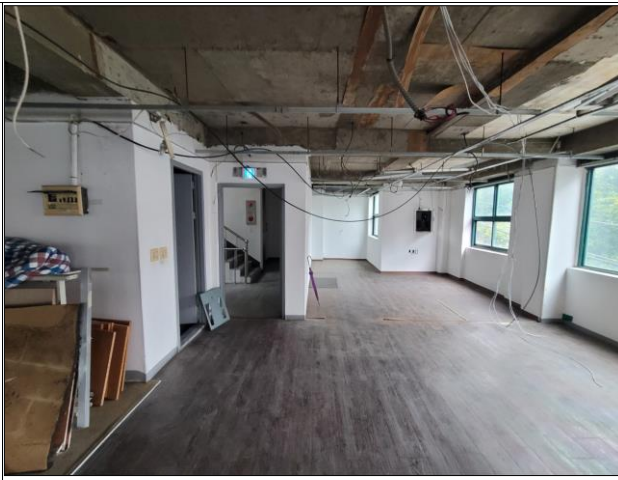
필동관 2층 천장 및 가벽등 철거완료
