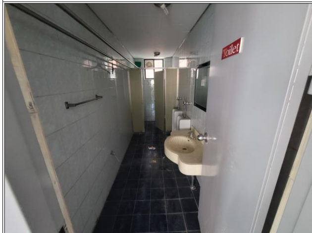
화장실 벽타일, 바닥타일, 천장 철거후 신규시공 (큐비클, 위생도기 철거 건축공사 포함)
