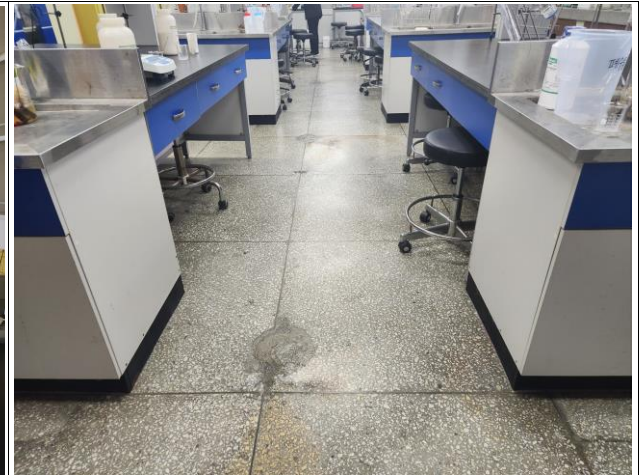
현바닥 바탕정리(요철부위 매움 및 그라인딩) 후 데코타일 시공
