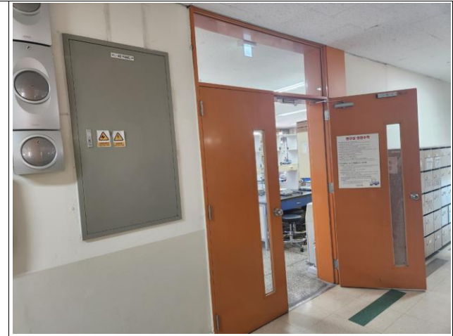
출입구 좌측벽체 존치 (철거시 유의 / 메인 전기판넬 이동불가)
