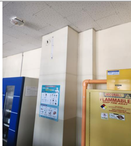
벽체 해체시 골조기동 확인후 해체(기동 주변 재질확인후 철거)
