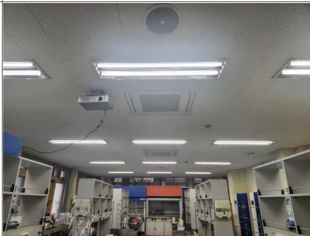
천장(텍스 및 경량천장들) 철거, 등박스 및 전기배관 철거 + 부착물(빔프로젝터, 감지기, 스피커 등) 임시제거후 재부착 포함
