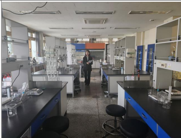
실험대 6EA, 소형 실험대(전자교탁 옆) 철거 후 폐기 + 일부 장비 및 집기류 임시이동후 재배치
