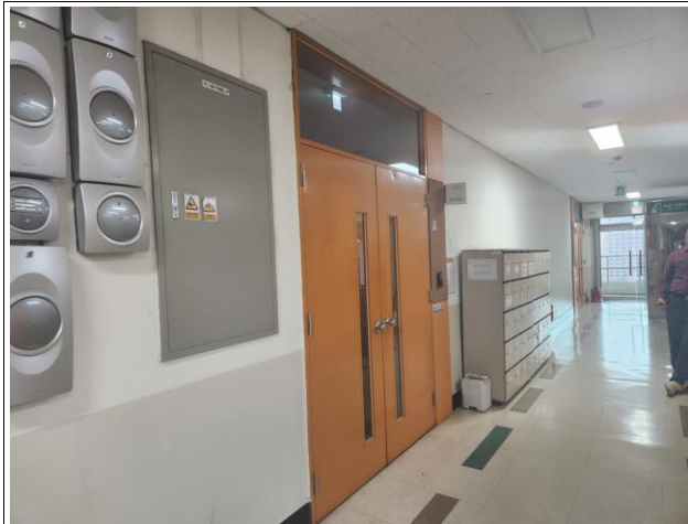
기존 출입문 및 벽체 철거후 신규 도어 및 유리벽체 시공
