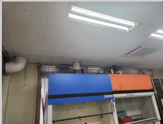
흡후드(기계 및 배관) 2EA 및 배관(천장매립부분 포함) 철거 후 폐기
