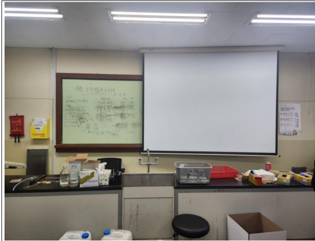
소형시험대, 칠판 철거 칠판(백페인트글라스) 및 주변 시트지 마감, 스크린용 커텐박스 매립
