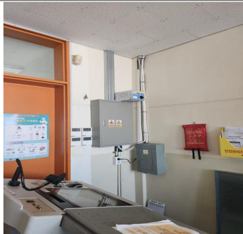
경량벽 + 갤러리 도어 설치(분전함 등 기존 판넬 유지) + 내부 도장 마감
