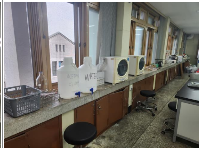
창호하부 인조석 존치(MDF+시트지 마감) + 하부장 철거후 신규 하부장 설치 + 커텐박스 및 블라인드 철거후 신규 설치(커텐박스 및 암막방염 블라인드)
